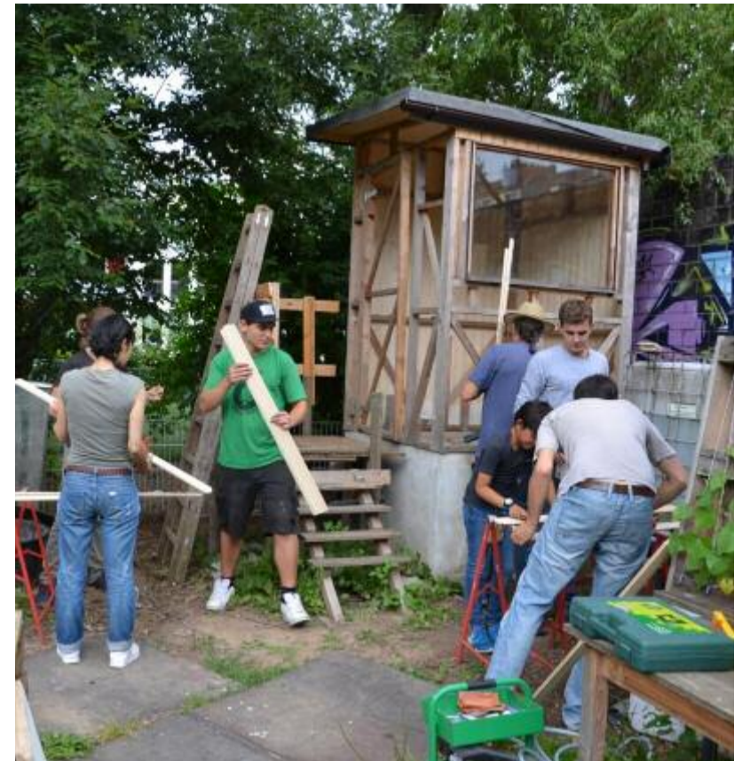
Das Sanitärprojekt vor Ort in Makali. (Foto: Ingenieure ohne Grenzen)
